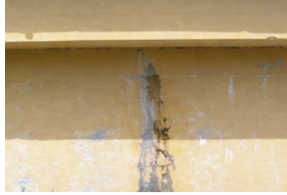
Juntas de dilatación
