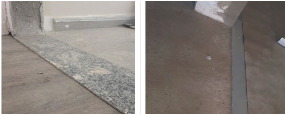
Nivelación de superficie
