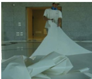
Desprendimiento de la película epóxica por falta de preparación correcta de la superficie
